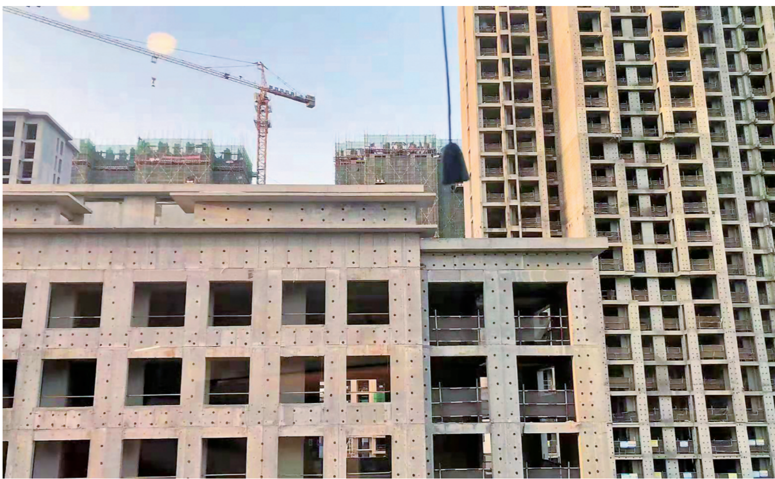
3月24日，河北固安一处正在建设的楼盘。受访者供图
